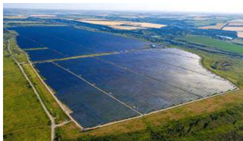
Мал. 226. Сонячна електростанція (м. Нікополь 2019 рік)
