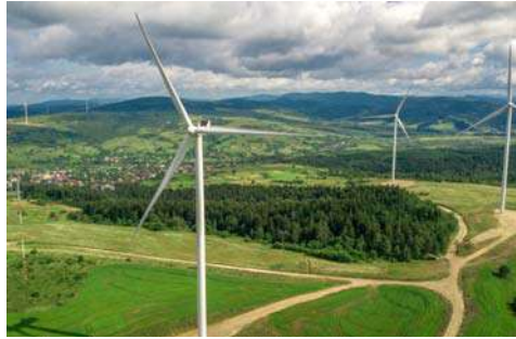
Мал. 227. Вітрова електростанція (м. Старий Самбір)
